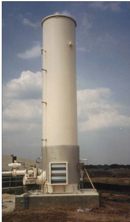
شکل ۲-۱۶. نمونه ای از یک فلر بسته زمینی (Enclosed Ground Flare) [۱۷]
