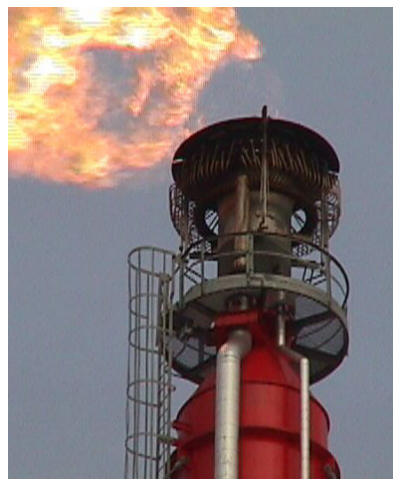
شکل ۲-۱۲. نمونه از یک فلر بدون دود بخار کمک برای ظرفیت های بالا
