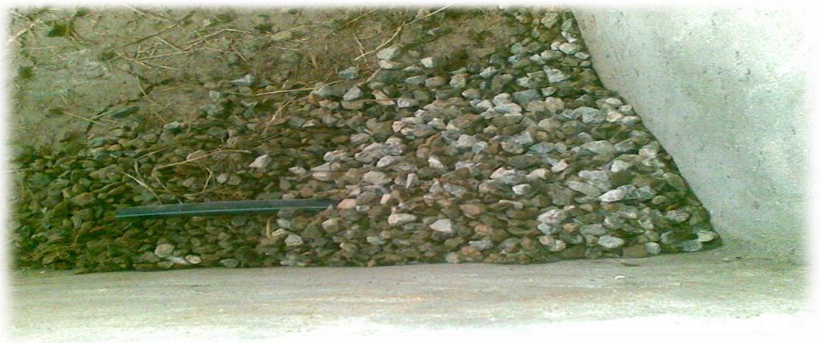
شکل ۲- لوله پوشیده شده با سنگریزه
